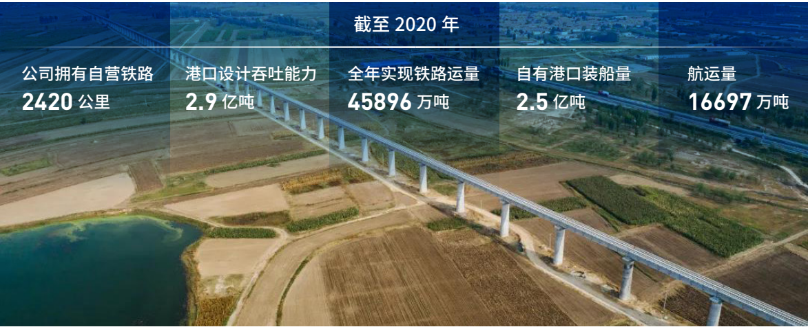
全长 16.22 千米的黄大铁路海兴特大桥
