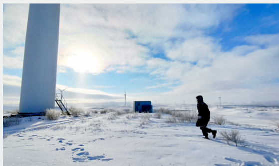
河北新能源康保风电场检修人员踏雪消缺争发电
