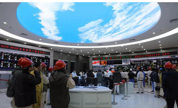
国华锦界电厂三期扩建工程 5 号机组集控室内景，该工程是世界首例高位布置汽轮发电机组
