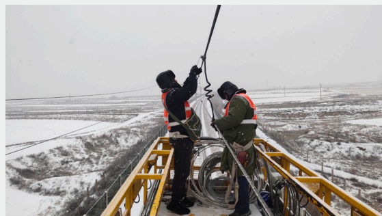
包神铁路集团包神铁路公司作业人员正在进行接触网检修
