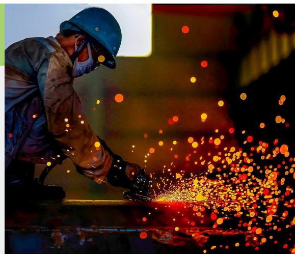
浙江公司宁海电厂磨煤机解体检修现场
