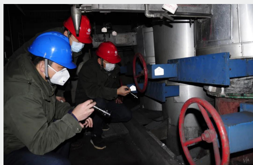
恢复东线供热管网
