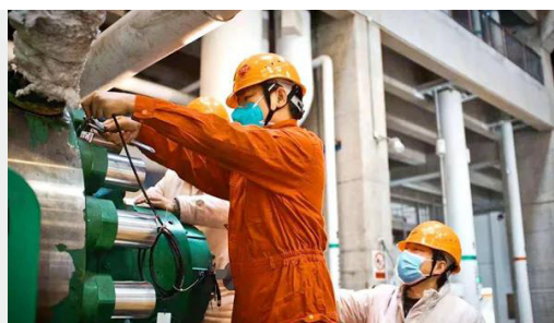
保障电力供应
